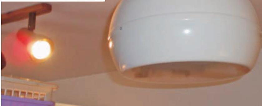
Dies ist der kleinstmögliche Generator zum Entfeuchten – Disc 2000 genannt – wie er beispielsweise in Kellern von Einfamilienhäusern zum Einsatz kommt. Die Antennenanordnung wurde hier mit einem Gehäuse verkleidet.
